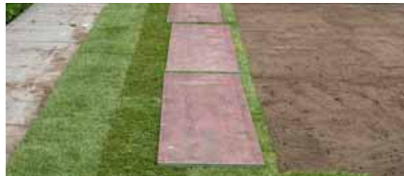
Verlegung des Fertigrasens im Verbund auf angefeuchtetes Planum, ohne dieses zu betreten
