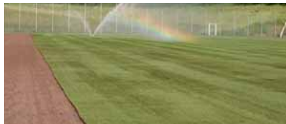
Umgehende Wässerung direkt nach der Verlegung
